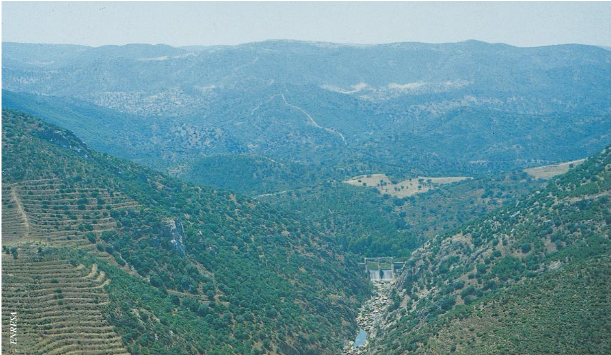
En las proximidades de las instalaciones de ENRESA en el Cabril, se sitúa la presa del río Bembézar
