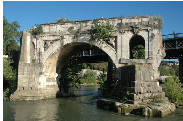
Figura 2: Restos del Ponte Rotto . Llamado originalmente Puente Emilio ( Pons Aemilius ), fue el primer puente de mampostería de Roma. Cruzaba el Tíber al norte del antiguo Ponte Sublicio . Fue remodelado y reconstruido varias veces hasta la inundación de 1598, que lo inutilizó para siempre.
